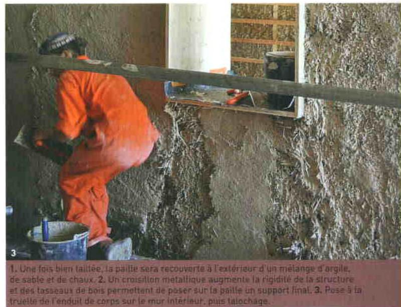
1. Une fois bien taillée, la paille sera recouverte à l'extérieur d'un mélange d'argile, de sable et de chaux. 2. Un croisillon métallique augmente la rigidité de la structure et des tasseaux de bois permettent de poser sur la paille un support final. 3. Pose à la truelle de l'enduit de corps sur le mur intérieur, puis talochage.
