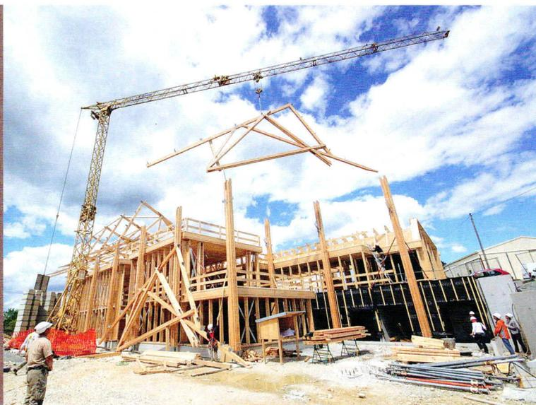
La structure en bois a été préfabriquée en atelier, puis montée sur site avec l'aide d'une petite grue.
