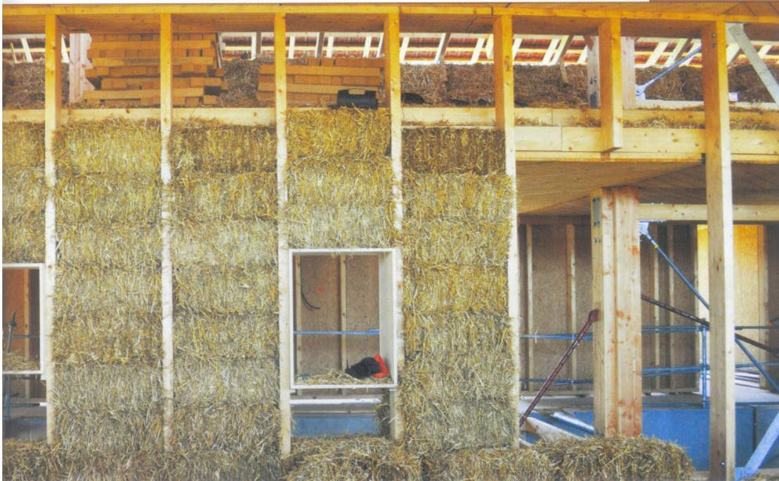
minée, 77 tonnes de paille – soit 4800 bottes de 85 x 35 x 45 cm – ont été livrées sur le chantier, puis mises en œuvre pour réaliser les murs par empilement et encastrement entre les poteaux en bois, à l'aide d'un maillet. Une fois mises en place, les bottes sont arasées à l'aide d'un débroussailleur, avant de recevoir un enduit extérieur de protection.
